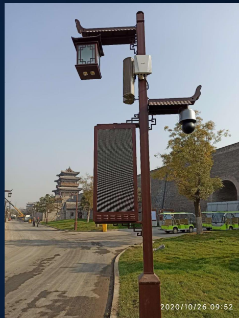
安装现场实拍
